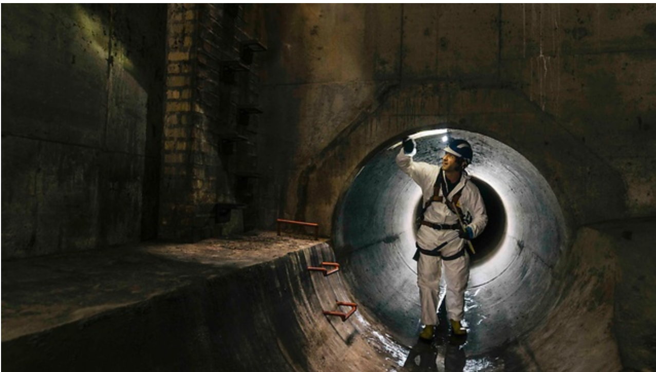
Daniel Liebing prüft die Wände in einem Regenwasserstaukanal.
